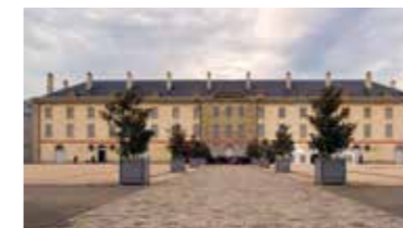
Façade et place d'armes du CNCS à Moulins.
